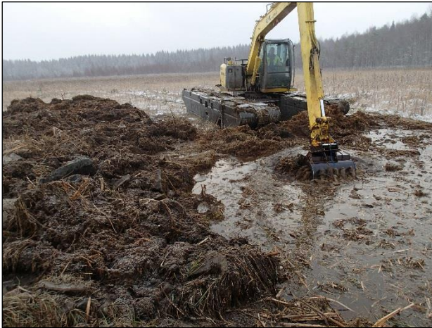
Vasemmalla: Ruoppaus käynnissä. Vesi estää näkyvyyden kaivantoon, joten havainnot on tehtävä läjityskasasta, joka näkyy kuvassa vasemmalla. Oikealla: Ylösalaisin läjityskasaan tippunut kauhallinen, josta näkee, että eloperäiset kerrostumat alkavat heti saven yläpuolelta, ilman kuivan maan kerrostumia.
